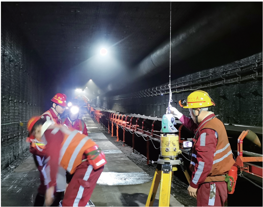
测绘院王志礼正在曹家滩煤矿井下聚精会神进行陀螺定向测量。（李小涛）
