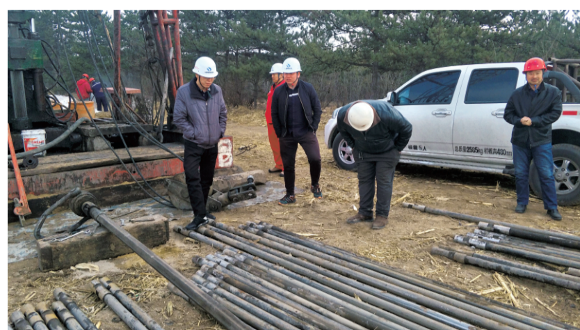
节后的榆林春回大地、气象万千。公司复工复产的号角此起彼伏，野外施工项目全面展开，公司生产安全督查工作随即跟进。
